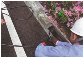
管路内の清掃
