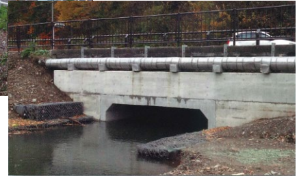
長寿命化(補強後)
