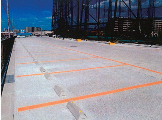
光触媒付き透水ポリコン舗装
