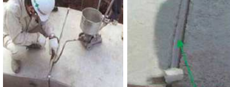
注入口より接着剤を注入 充填状況(接合完了)
