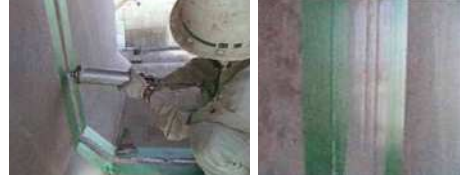
コーキングガンにより接着剤を内目地に充填
