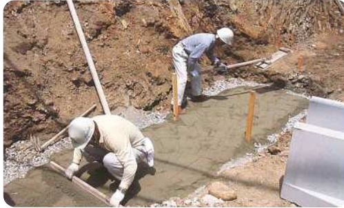
①基礎砕石工、敷モルタル工
