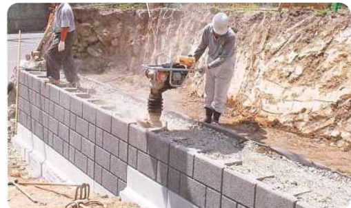
⑥中詰材投入・転圧、裏込材投入・転圧
