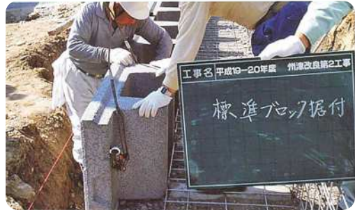
④ポラス(標準)ブロック据付
