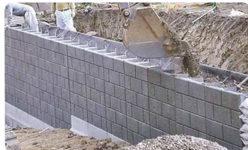
⑦段積み作業
