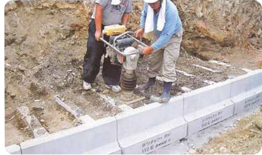
②根石ブロック据付、中詰材投入・転圧
