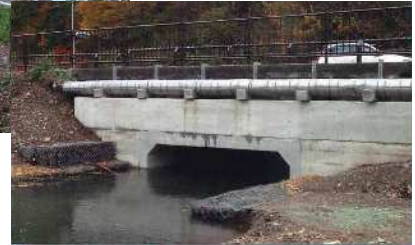
長寿命化(補強後)
