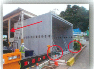
横引き施工（横引き前） ※上記「施工手順 ③」
