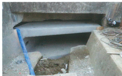
横引き完了直後（隙間は充填）
