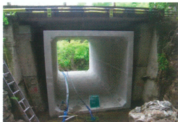
横引き完了直後（隙間は充填）
