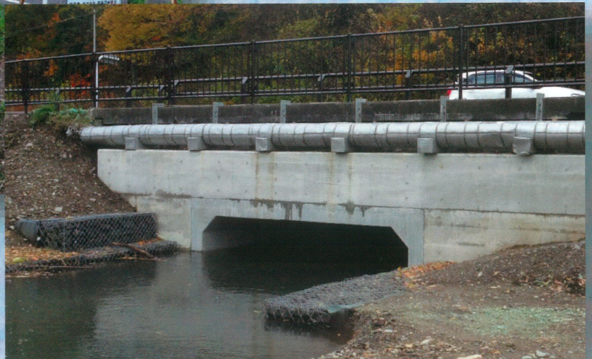
長寿命化（補強後）
