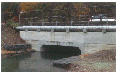
長寿命化（補強後）
