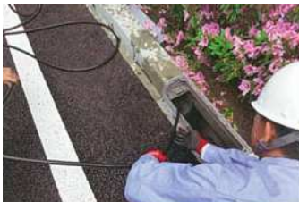
管路内の清掃
