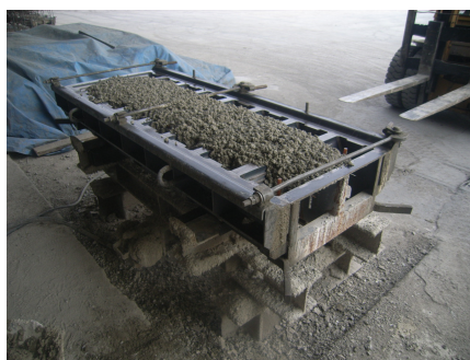
② 生コン打設&機械振動
