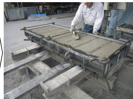
③ 表面コテ均し（製品底部）
